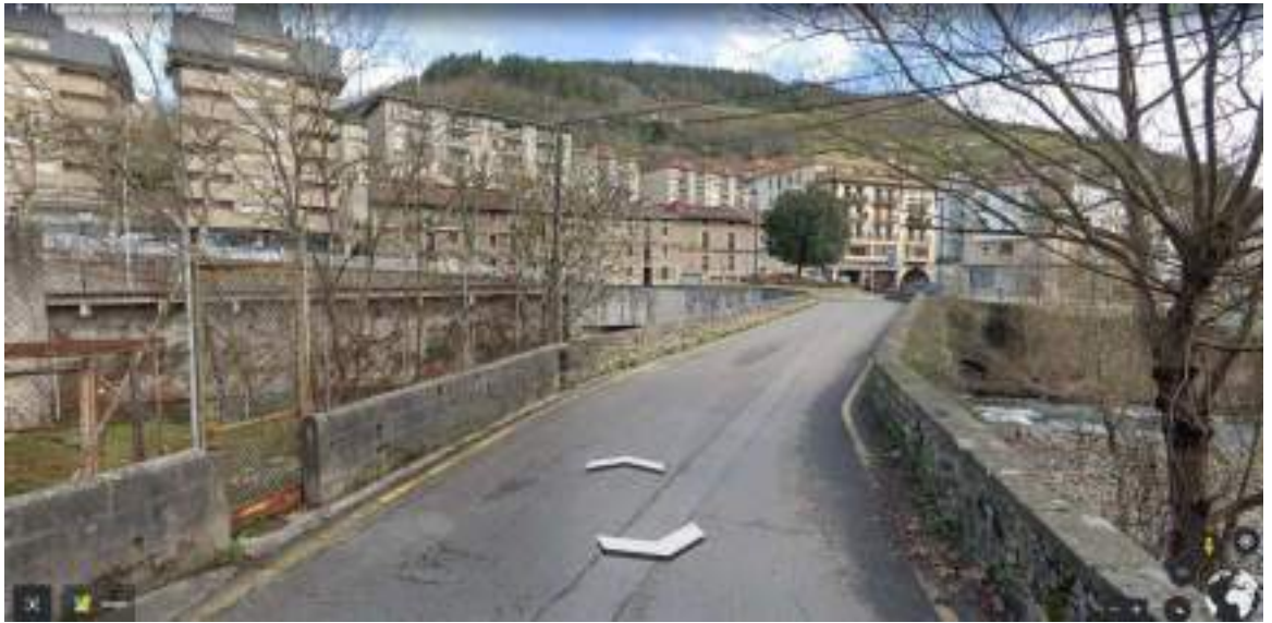
Puente sobre el río Deba en Gabiria Kalea.
