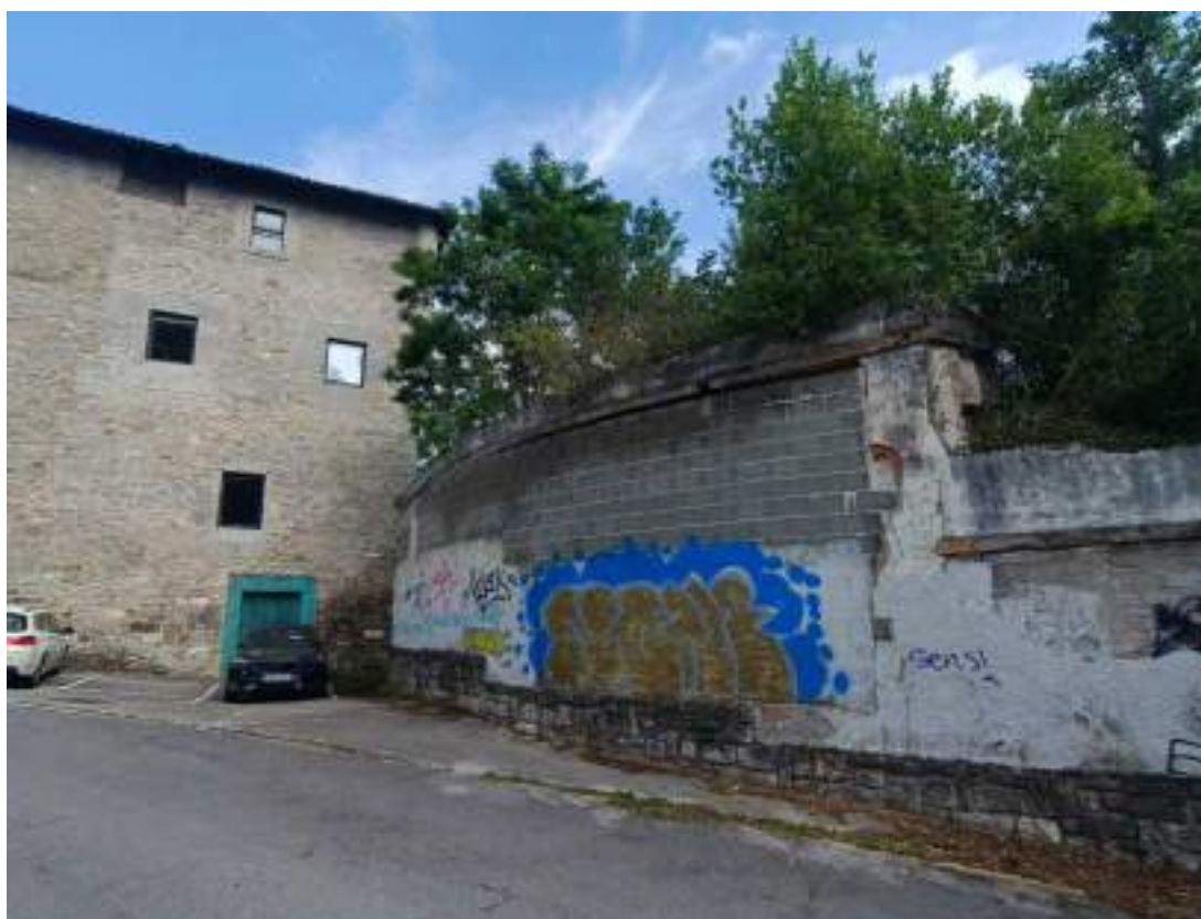
Ilustración 6. Unión del muro de cerramiento con la Torre Gabiria.
