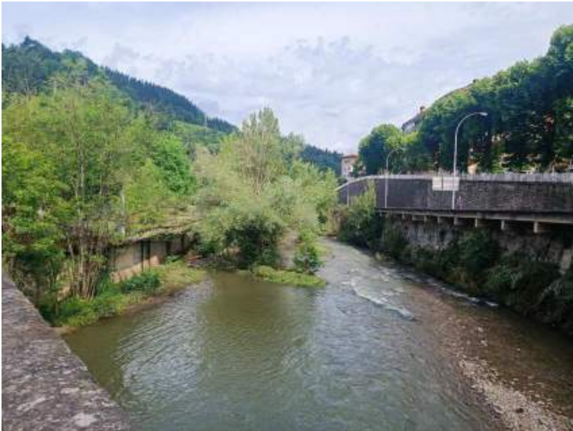
Ilustración 13. Fotografía desde el puente Gabiria.
