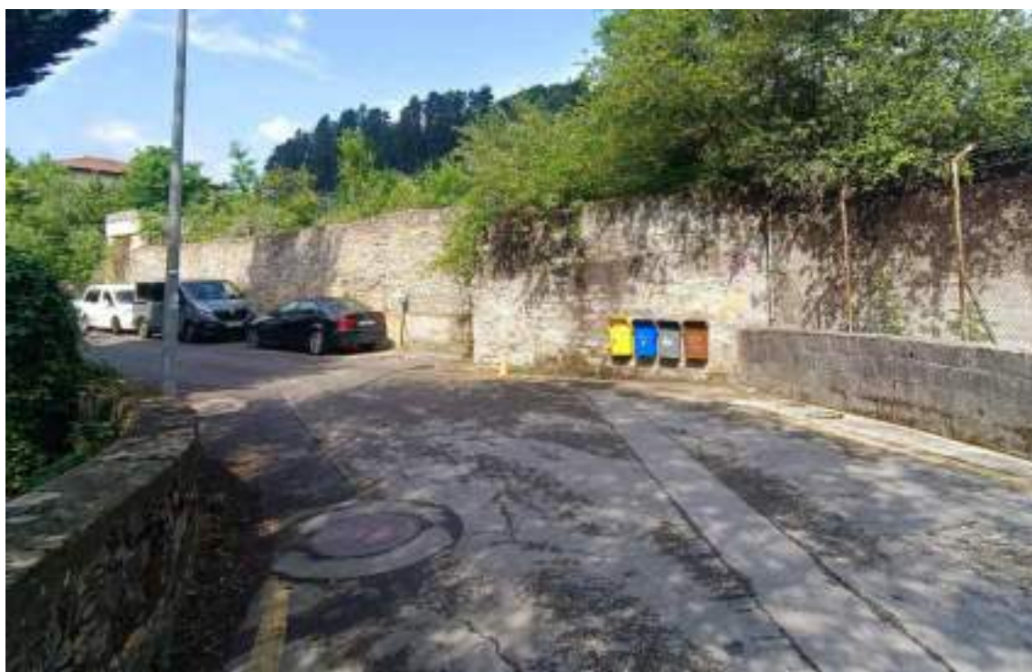
Ilustración 9. Zona de empalme del muro de la antigua Algodonera con el puente Gabiria.
