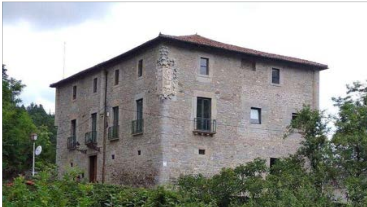
Figura 38. “Torre Gabiria”, edificio integrante del patrimonio construido Declarado Bien Cultural del País Vasco.
