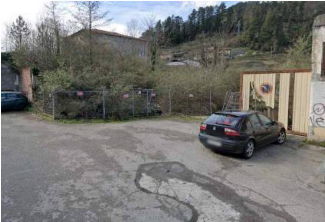
Ilustración 11. Apertura del muro en la zona central.
