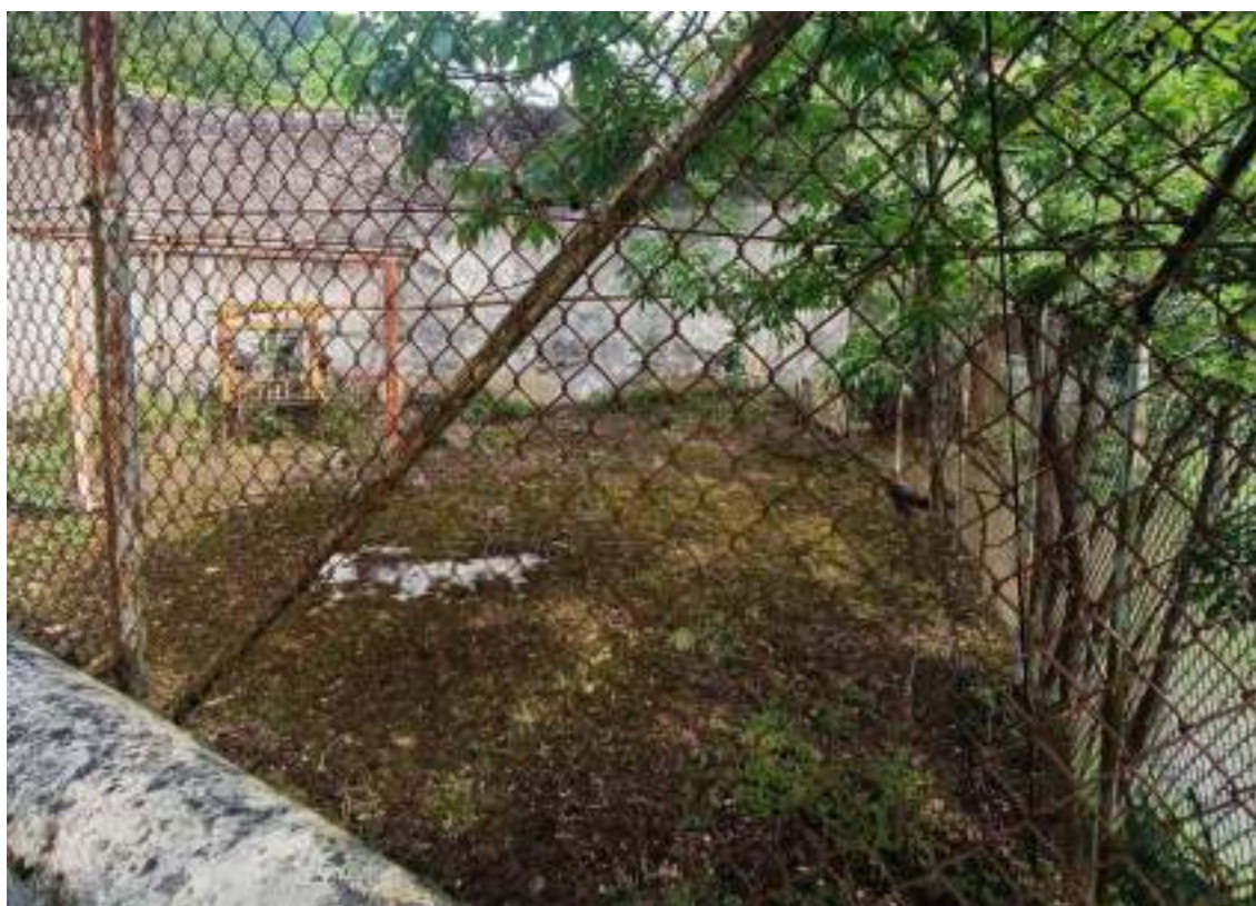
Ilustración 10. Final del muro en la zona del puente Gabiria.
