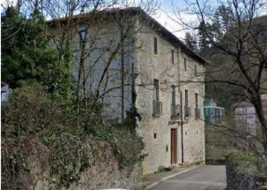
Torre Gabiria : Vista desde el lindero Oeste.
