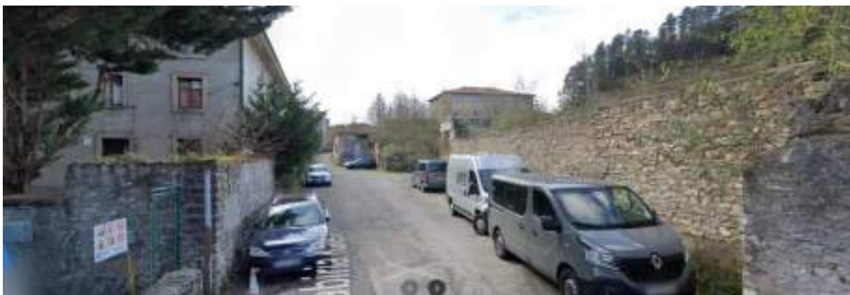
Ilustración 4. Imagen actual de la calle Gabiria, desde el estribo situado en la parcela del puente Gabiria.
