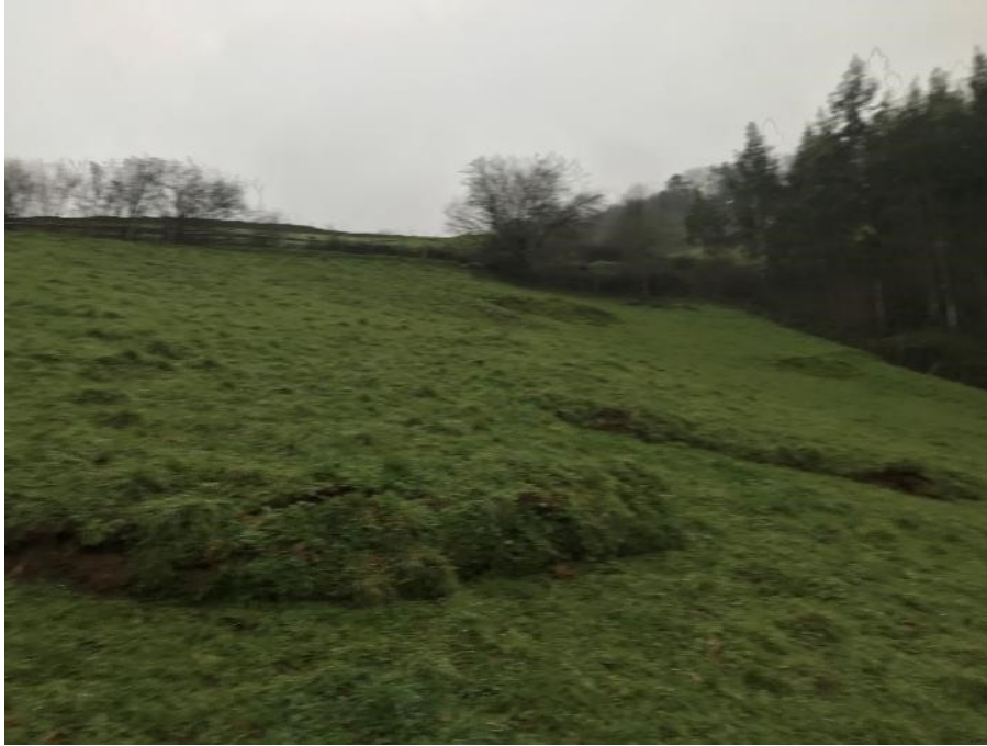
Fig 9: zona inferior del deslizamiento lóbulo de deformación en la zona de "salida" de la masa deslizada.
