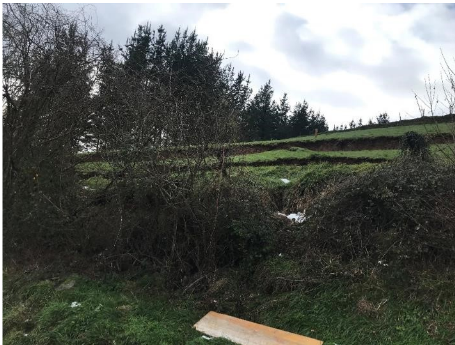
Fig 7: grietas de tracción del deslizamiento observadas desde la carretera.
